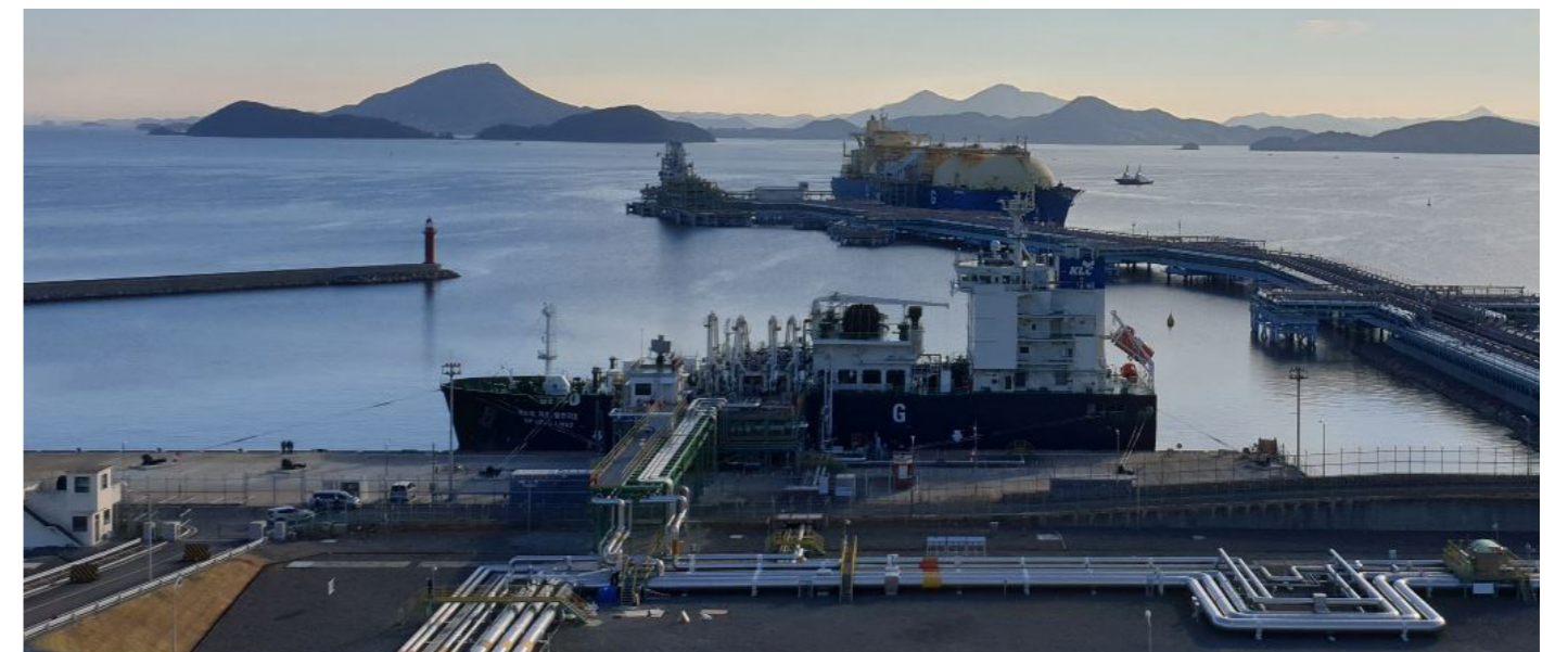
TY LNG Terminal - Courtesy of Kogas
