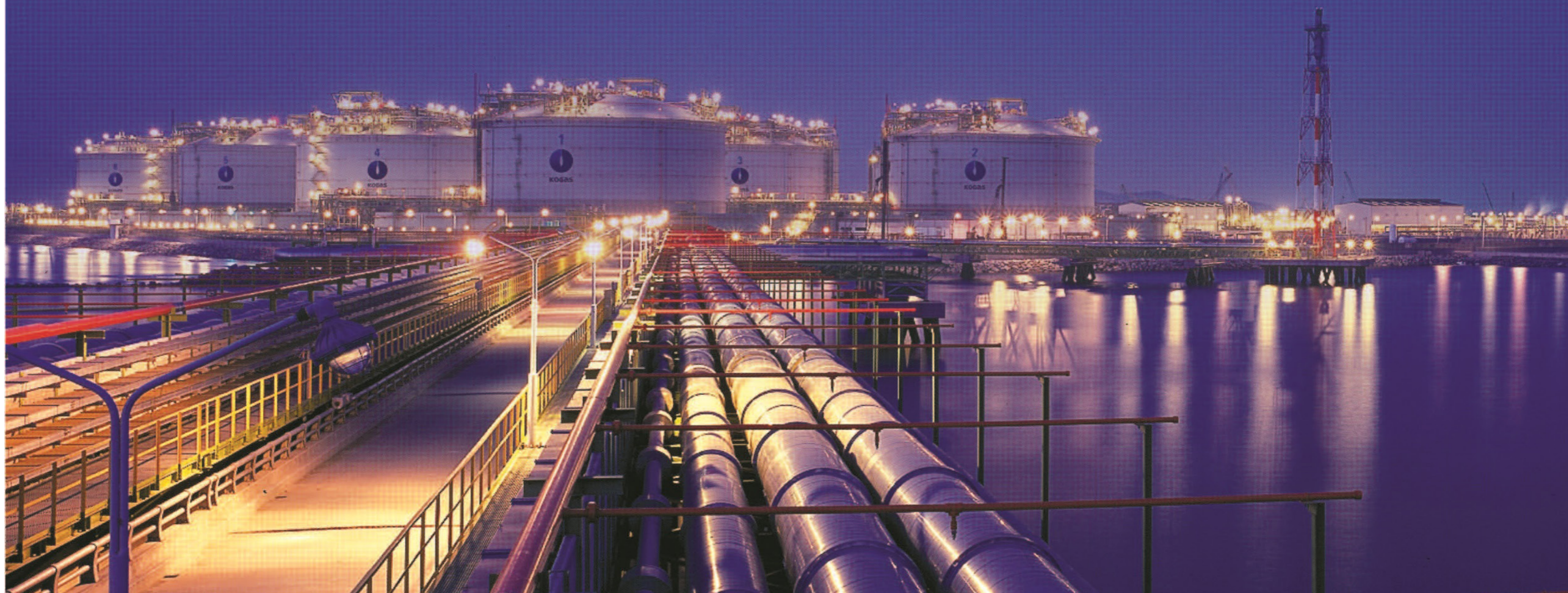
Incheon LNG Terminal - Courtesy of KOGAS
