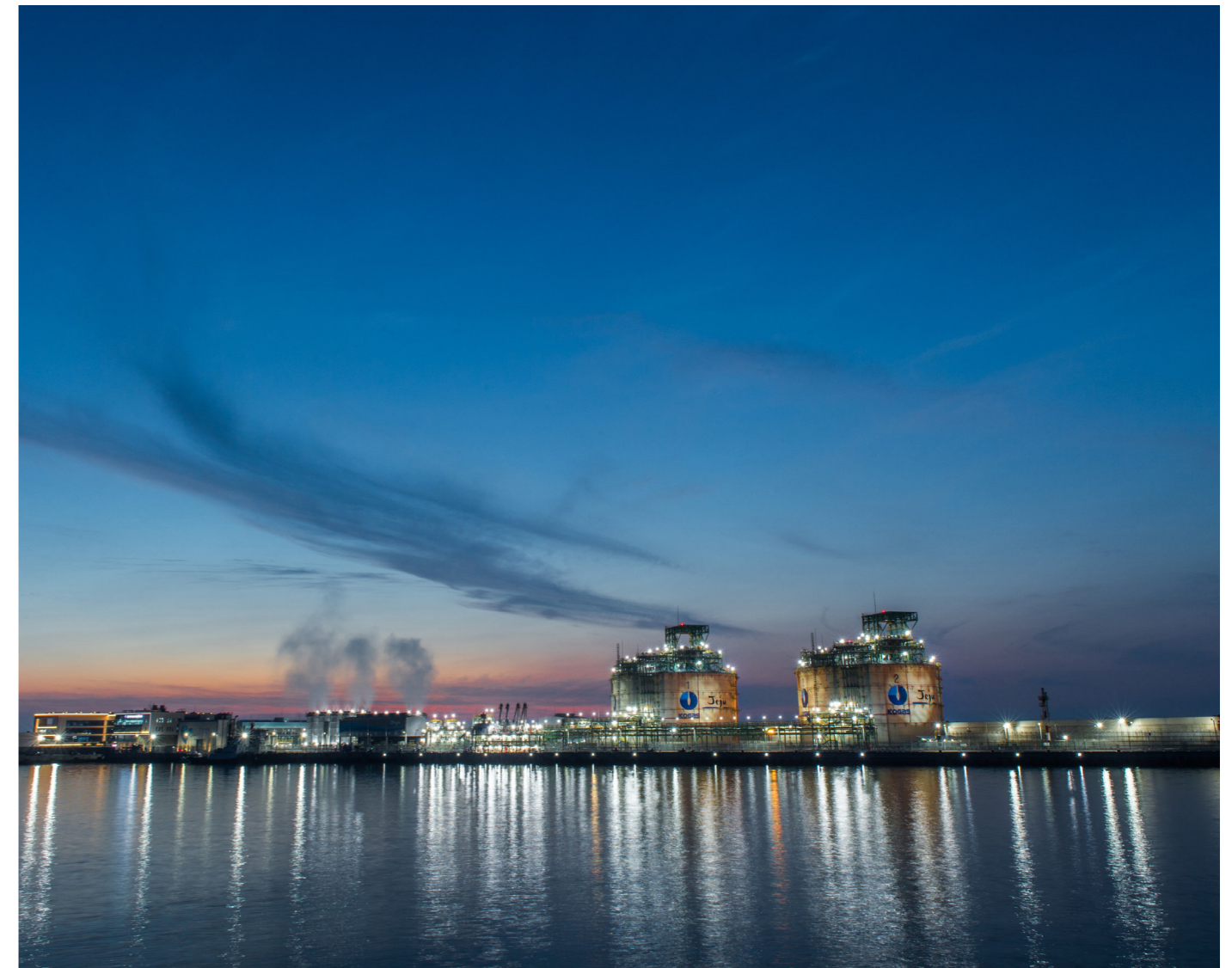
Jeju LNG Terminal - Courtesy of KOGAS
