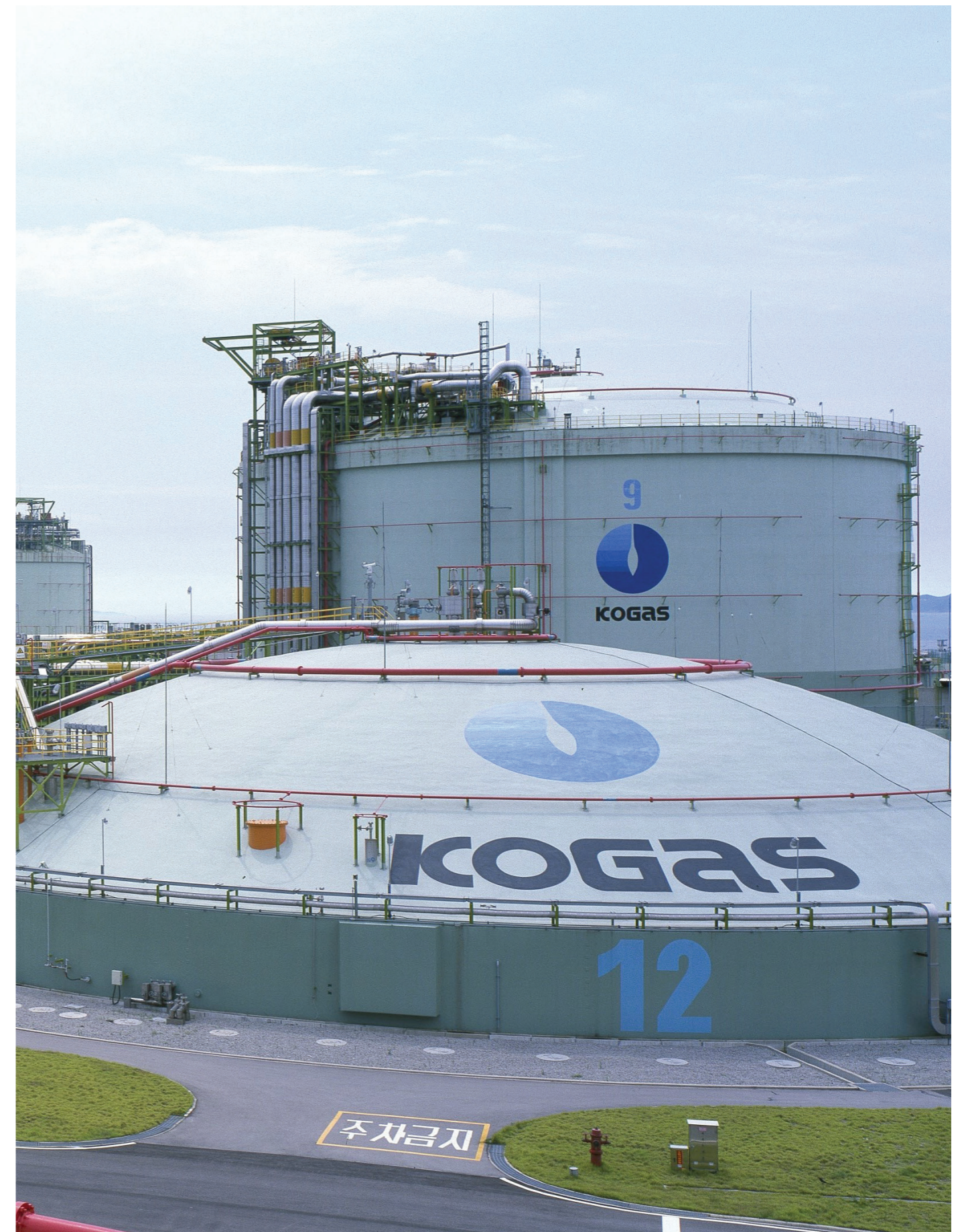
Incheon LNG Terminal - Courtesy of KOGAS
